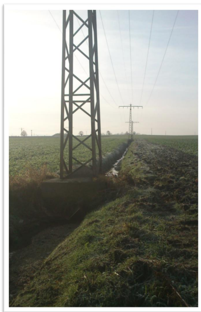
Fot. 18. Słupy średniego napięcia posadowione na przepustach między działkami 611/4 i 614/2.
