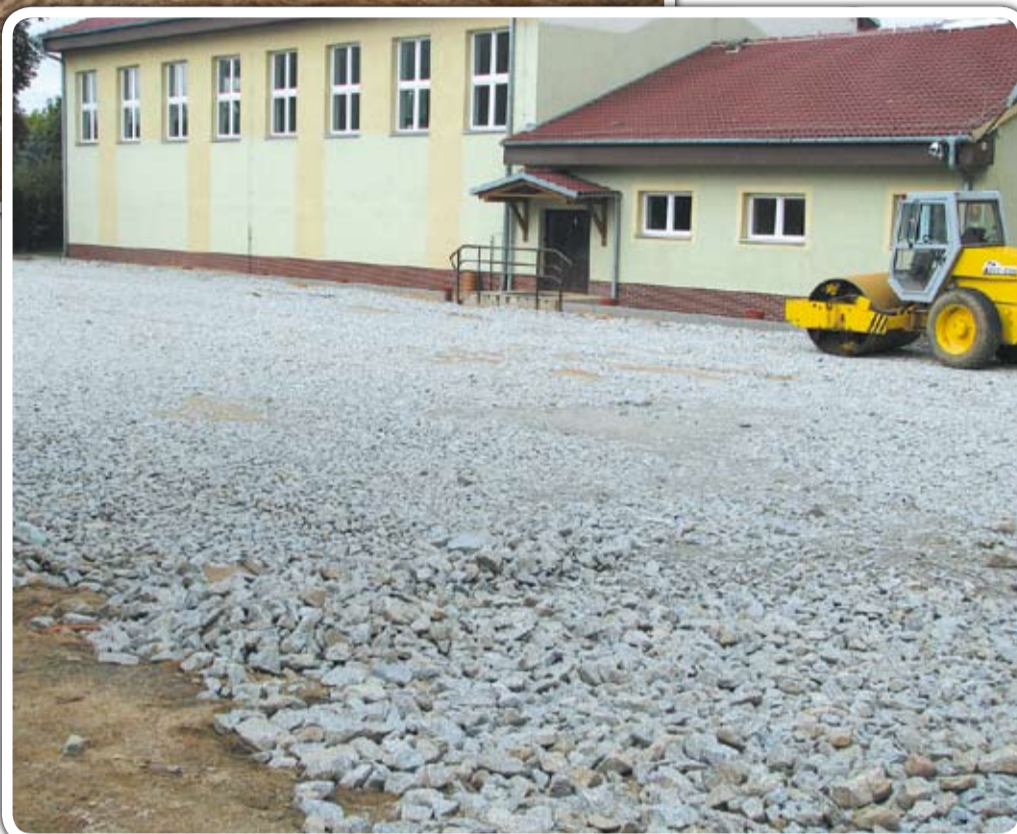
► Przy sali powstaje boisko wielofunkcyjne o wymiarach 20 m x 44 m, służyć będzie do gry w piłkę. Nawierzchnia boiska zostanie wykonana z tworzywa poliuretanowego z podbudową z kruszywa kamiennego oraz drenażem odwadniającym powierzchnię boiska. Teren przyległy zostanie utwardzony kostką betonową. Boisko zostanie ogrodzone siatką o wysokość 4 m
